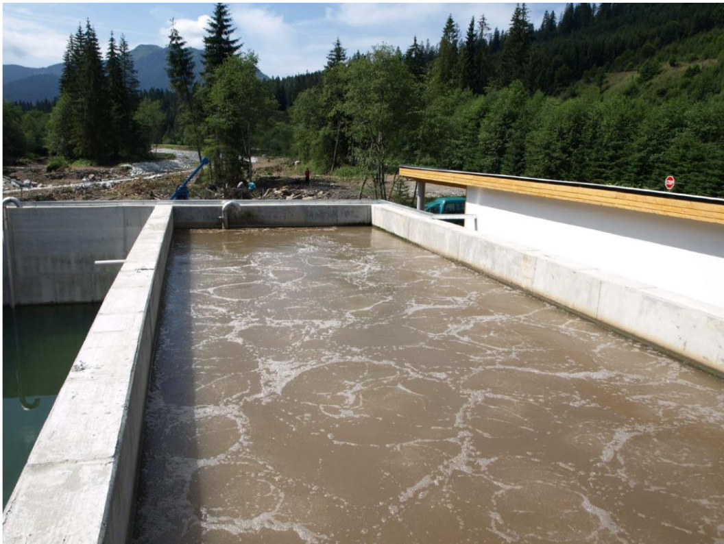
Obr. 18 ČOV Oravice aretační nádrž
