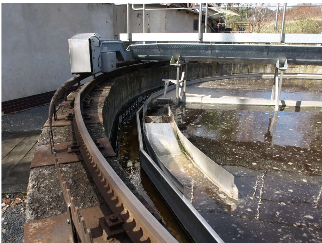
Obr. 22 Dosazovací nádrž 12 m detail pohonu
