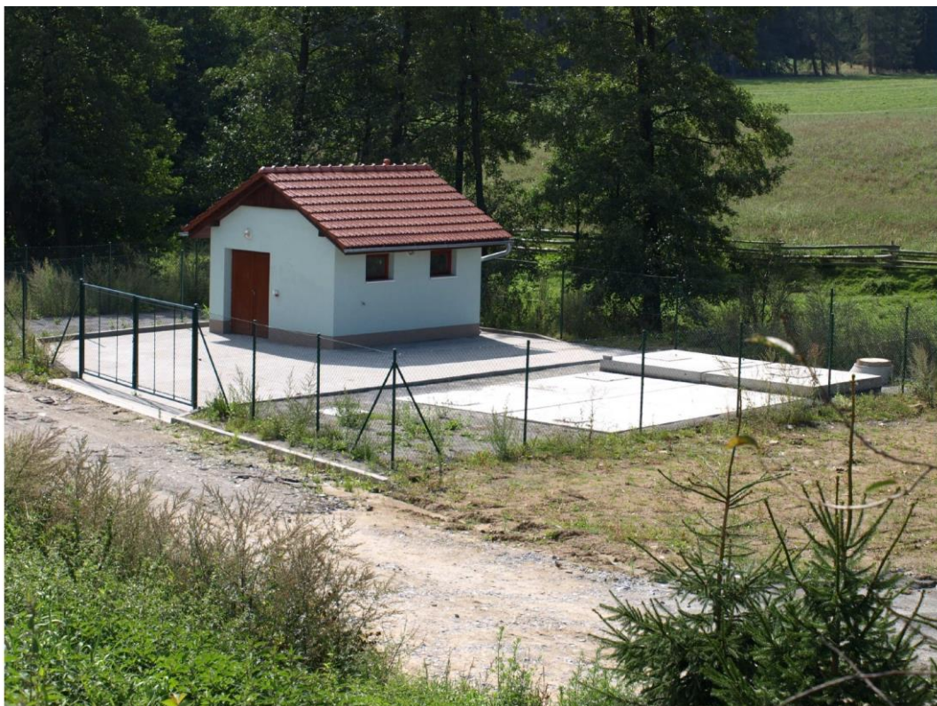
Obr. 13 ČOV Nihov celkový pohled
