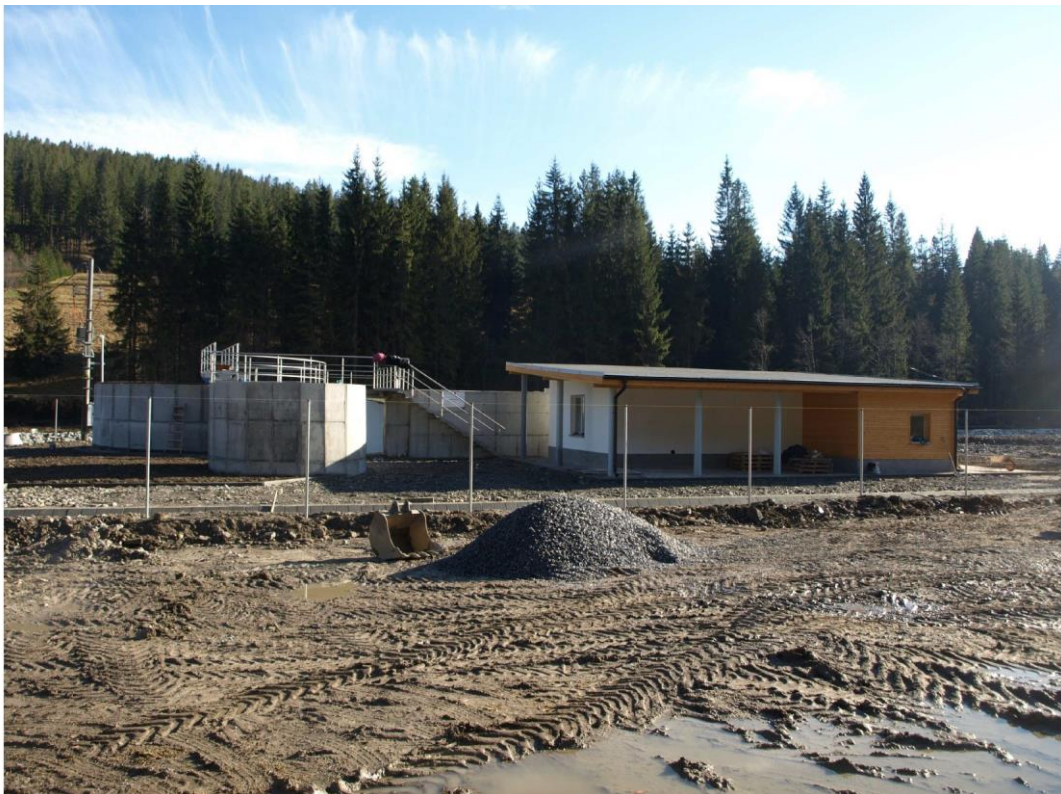
Obr. 17 ČOV Oravice celkový pohled
