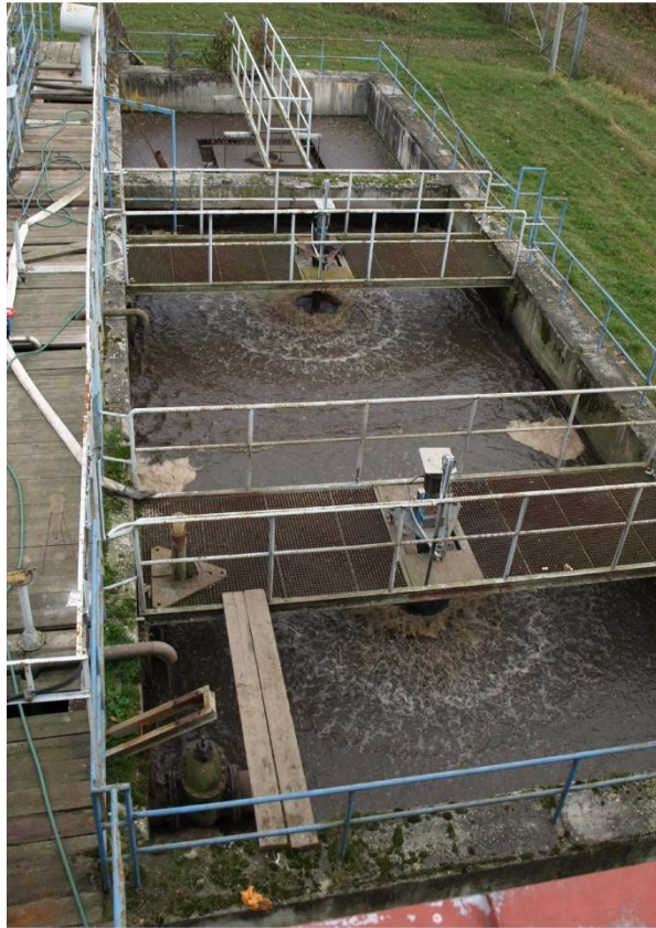
Obr. 6 ČOV Dub nad Moravou před rekonstrukcí
