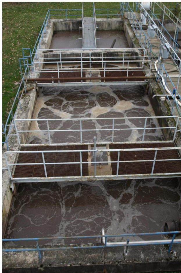
Obr. 7 ČOV Dub nad Moravou po rekonstrukci
