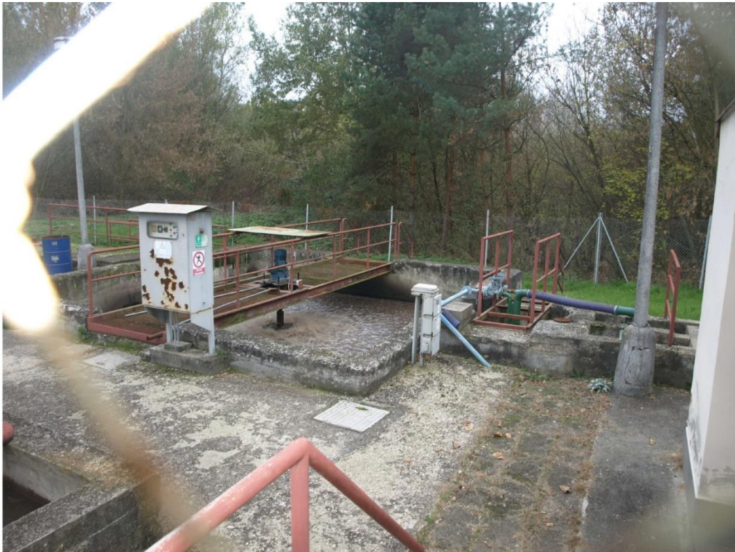
Obr. 5 ČOV Bzenec celkový pohled
