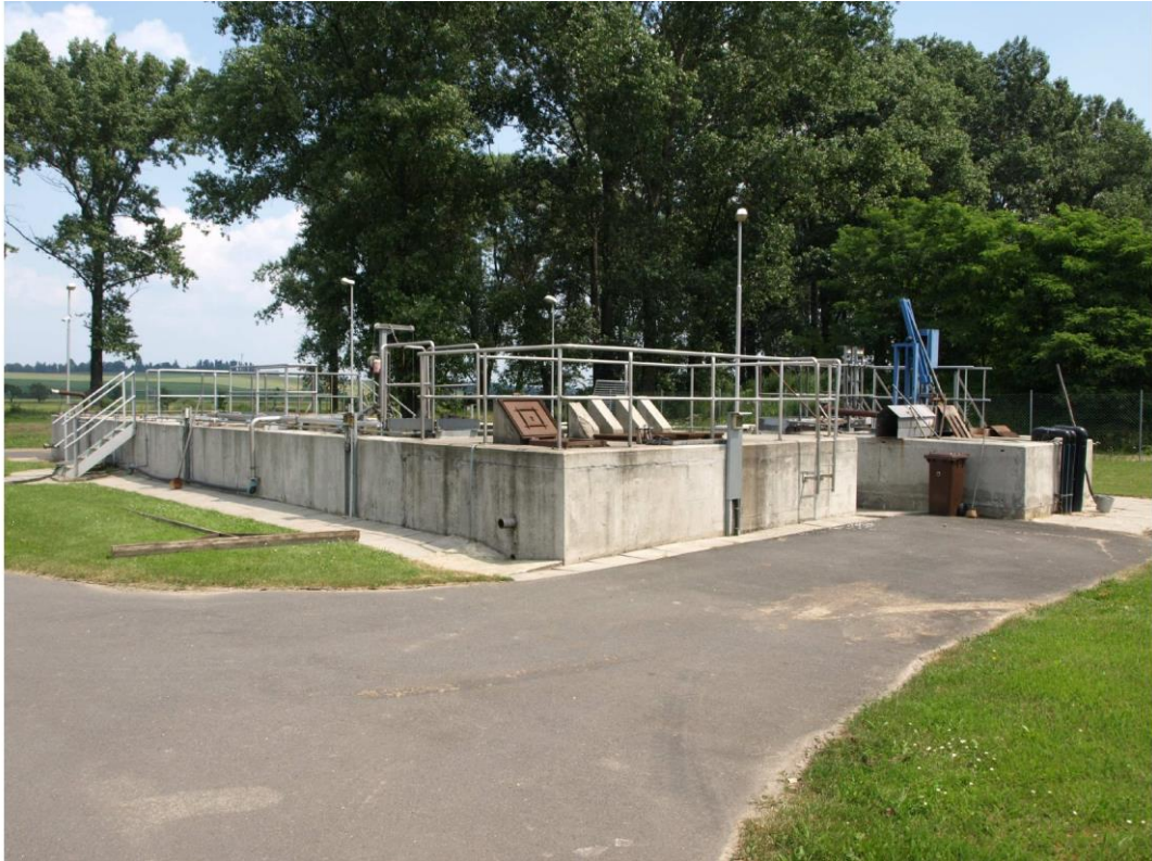
Obr. 14 ČOV Otice celkový pohled
