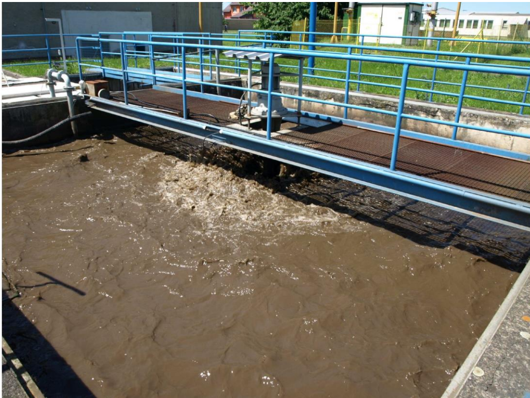
Obr. 8 ČOV Chválkovice celkový pohled
