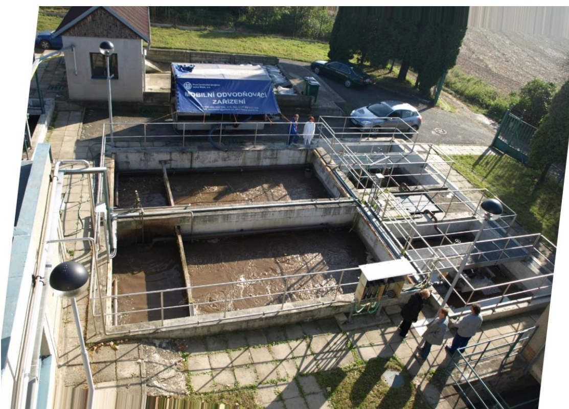
Obr. 2 ČOV Paseka po rekonstrukci
