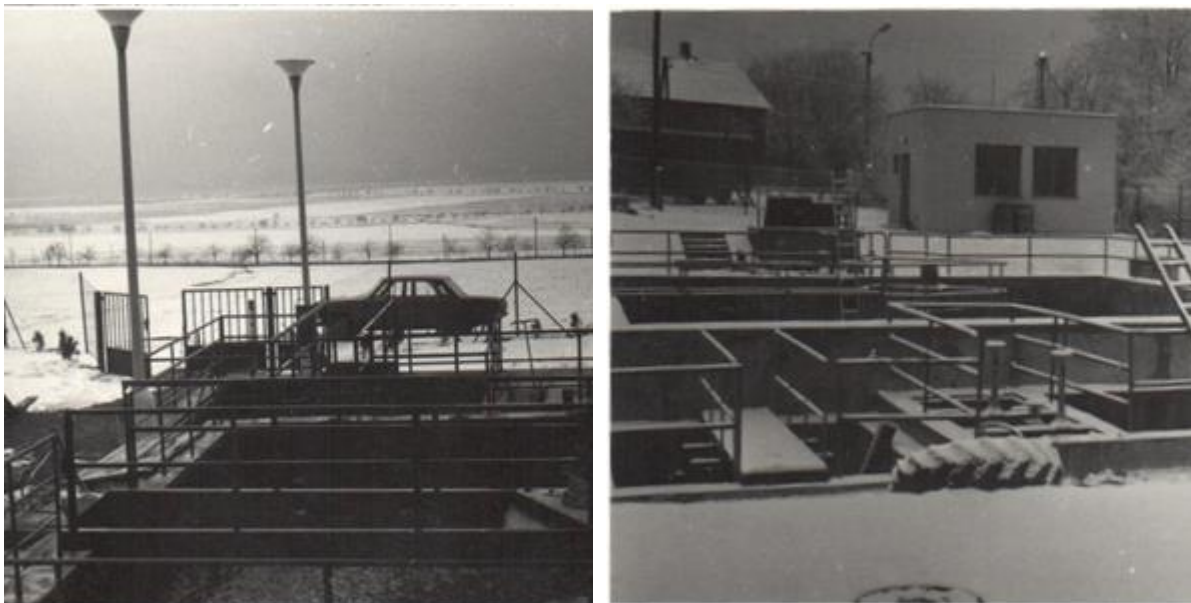
Obr. 1 ČOV Paseka r. 1970
