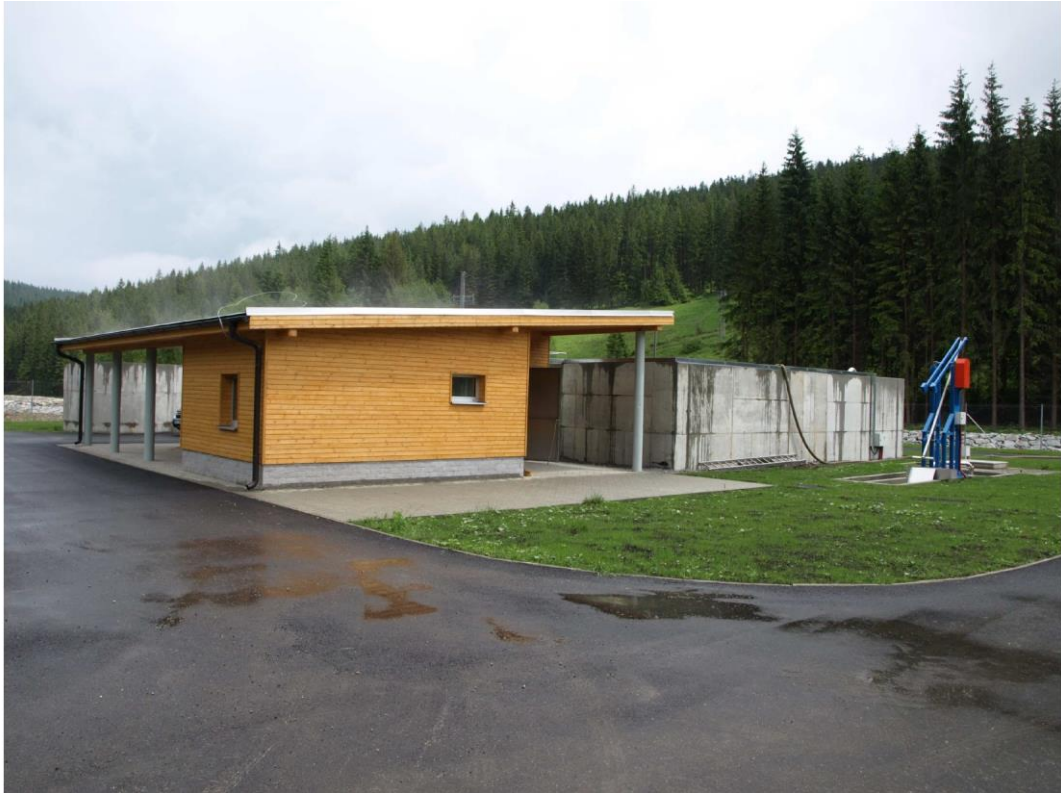
Obr. 16 ČOV Oravice celkový pohled
