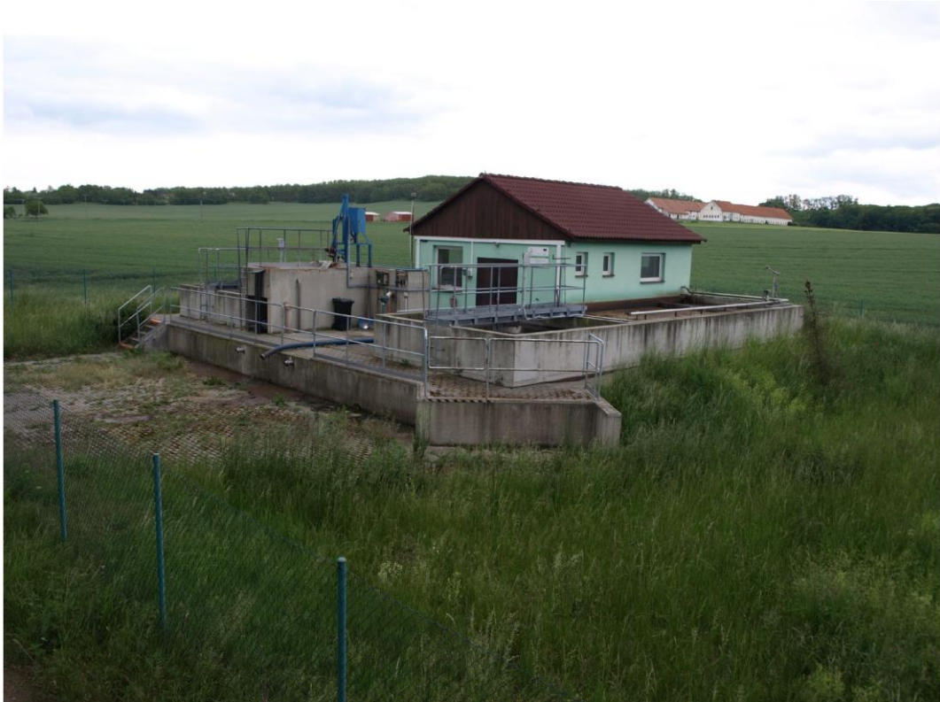
Obr. 10 ČOV Horní Dubňany celkový pohled
